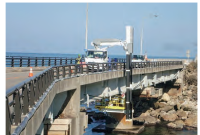
橋梁点検の状況
