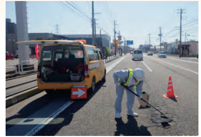
舗装補修の状況
