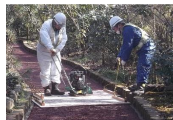
施工(敷均し、転圧、トップコート)
