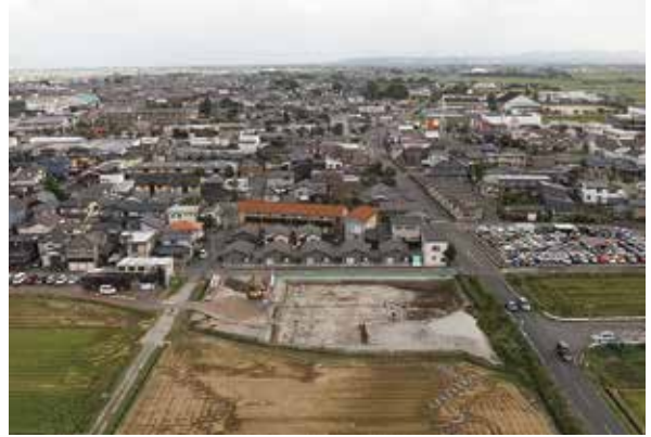
調査地遠景（北から）
