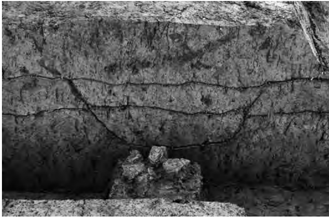
SK219 土層断面 (北→南)
