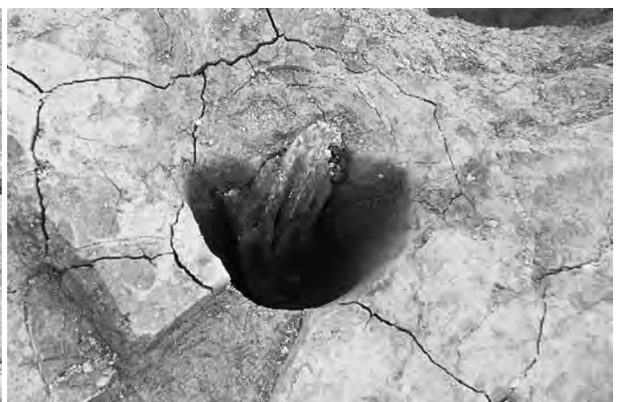
SA1544 P3 土層断面 (北西→南東)
