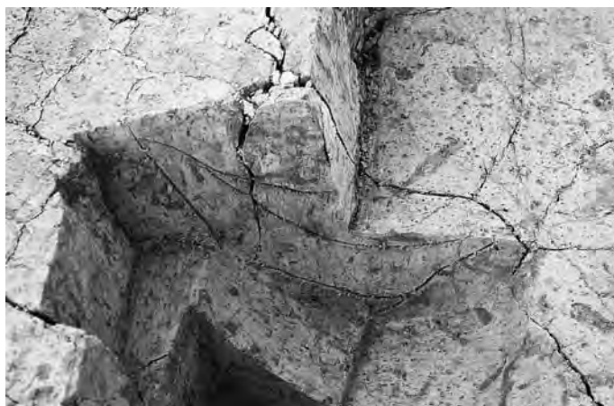
SK1177 土層断面 (北→南)
