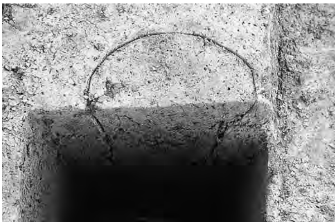
SB4 側柱 P448 南北セクション (東→西)
