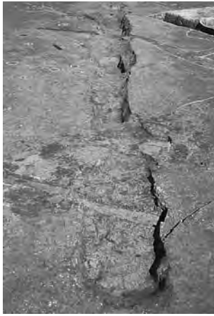
SD477 完掘 (南西→北東)
