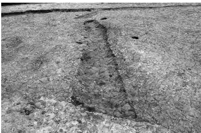
SD99 完掘 (西→東)
