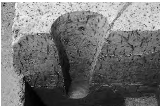
Pit438 完掘 (東→西)
