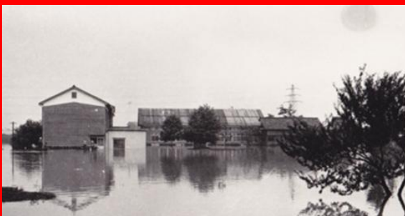
S41.7 7・17水害時の早通小学校の校舎が浸水している様子
