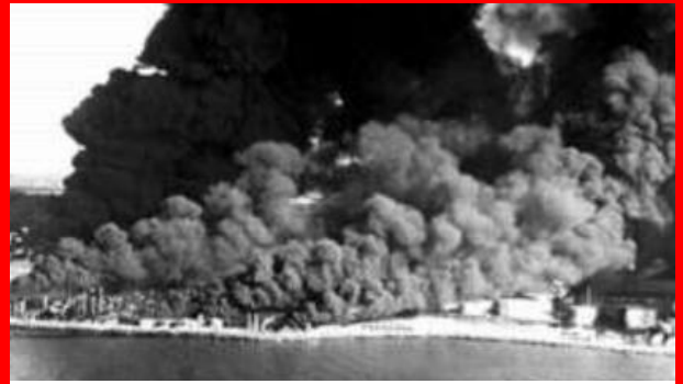
S39.6 新潟地震時の昭和石油タンクの様子
