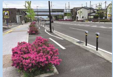
整備後の新潟鳥屋野線 (2020年3月)
