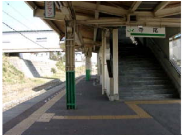
写真5.32 寺尾駅のホーム
