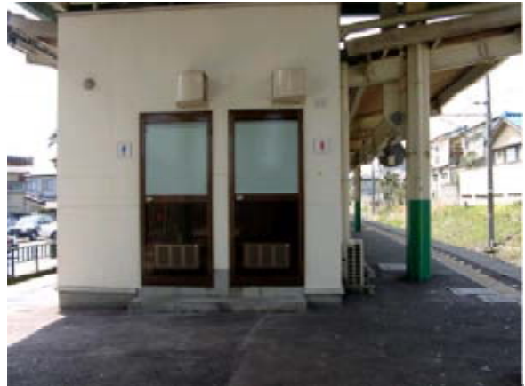
写真5.33 ホームにあるトイレ
