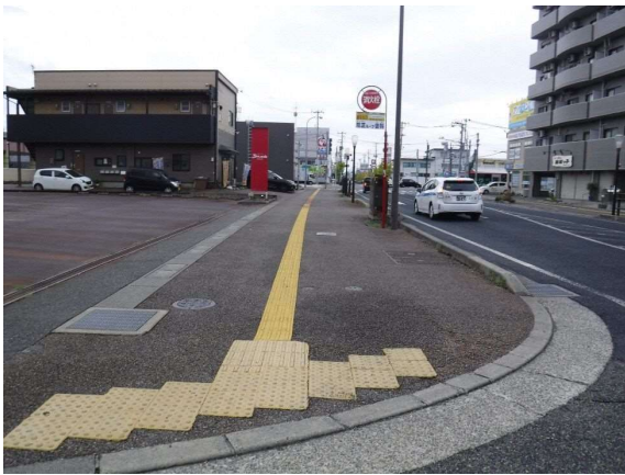
写真 2-3 視覚障害者用誘導ブロック
