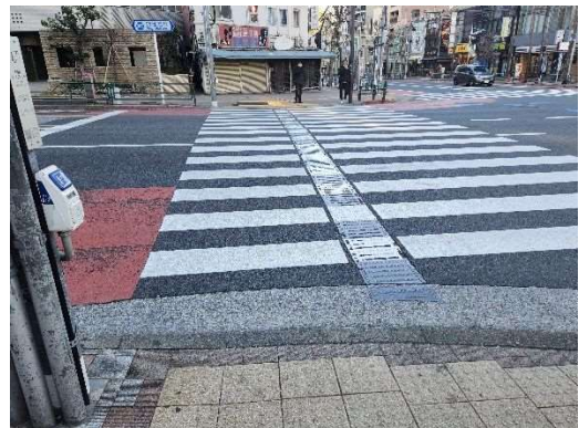
写真 6-6 エスコートゾーン
