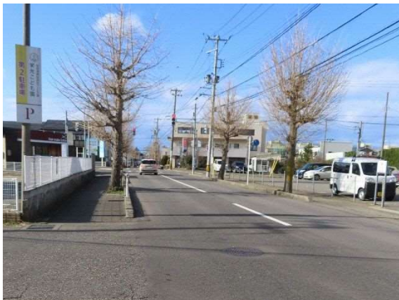
写真 6-36 石山地区センター前の道路
