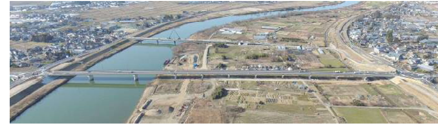
国道460号【新】臼井橋
