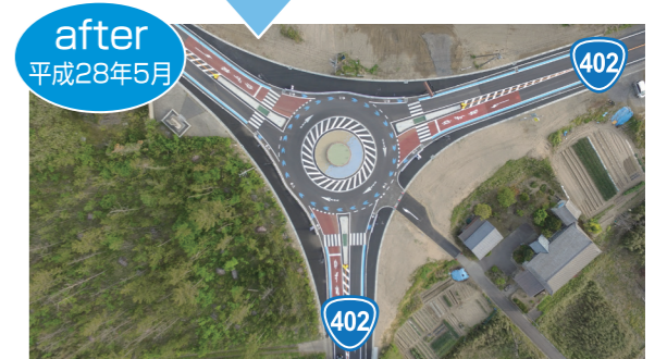
国道402号のラウンドアバウト (角田浜交差点)
