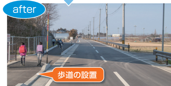
歩道設置 (秋葉区・新関小学校)
