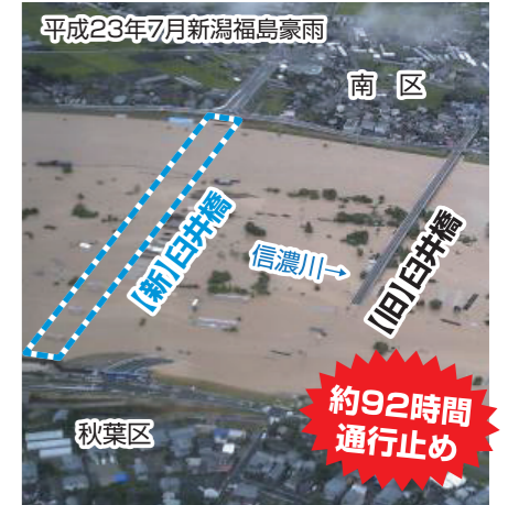
【旧】白井橋 通行止めの様子
