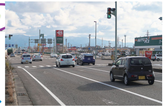
③ 供用済み区間 (北区エリア)
