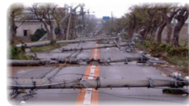
災害で道をふさぐ電柱 出典：国土交通省HP
