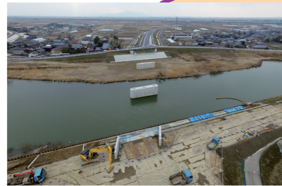
② 事業中区間 (中ノ口工区)
