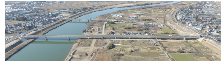
国道460号【新】白井橋
