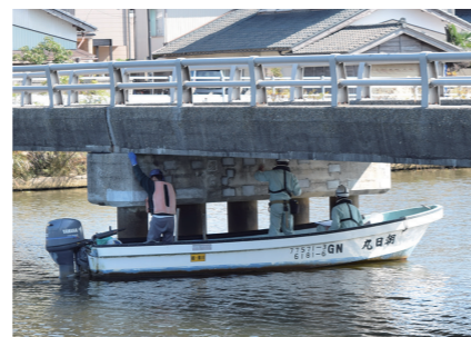
橋りょう点検の様子
