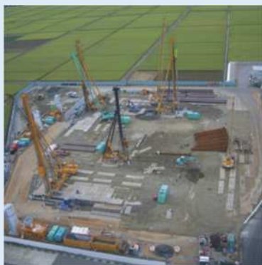
建設工事の実施 (現施設の解体工事を含む)
