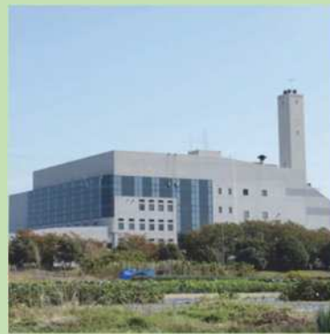
施設の配置・稼働及び 煙突からの排ガス
