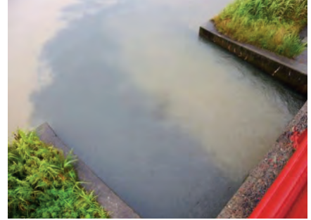
中部下水処理場の放流口
