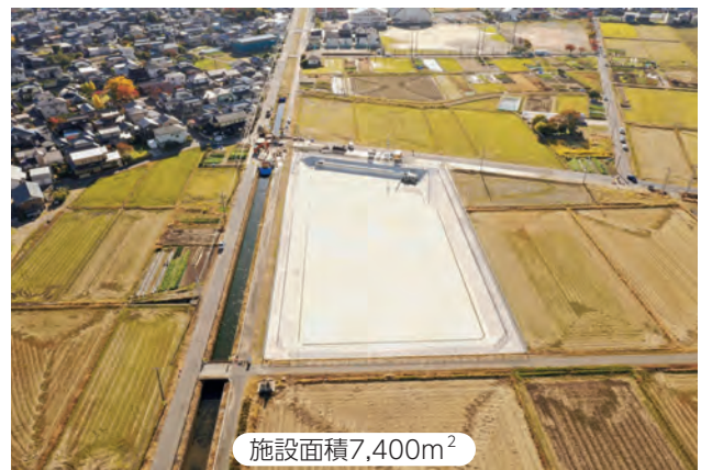
【横越雨水調整池】貯留量6,600m 3
