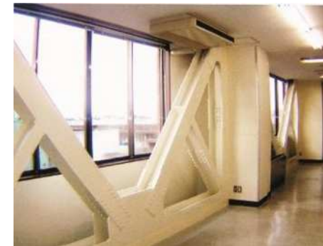
下水処理場の耐震化
