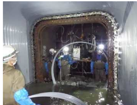
下水道管渠の改築工事
