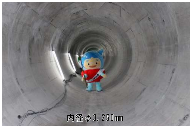
【大石2号貯留管】貯留量16,700 m ³
