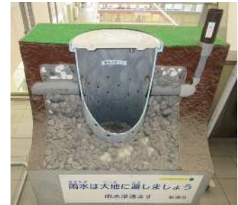
雨水浸透ます
