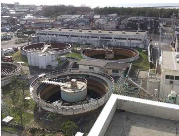
【再構築を行う船見下水処理場】
