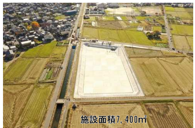
【横越雨水調整池】貯留量6,600 m ³
