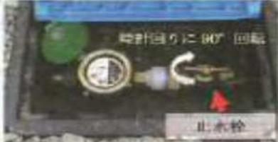
止水栓を閉めることにより、水漏れを止めることができます。冬期間、長期不在にするときは、止水栓を閉めることで凍裂被害の防止につながります。
