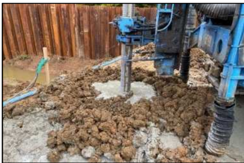
◀沈下防止工事の工事中写真の例
