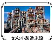
セメント製造施設
