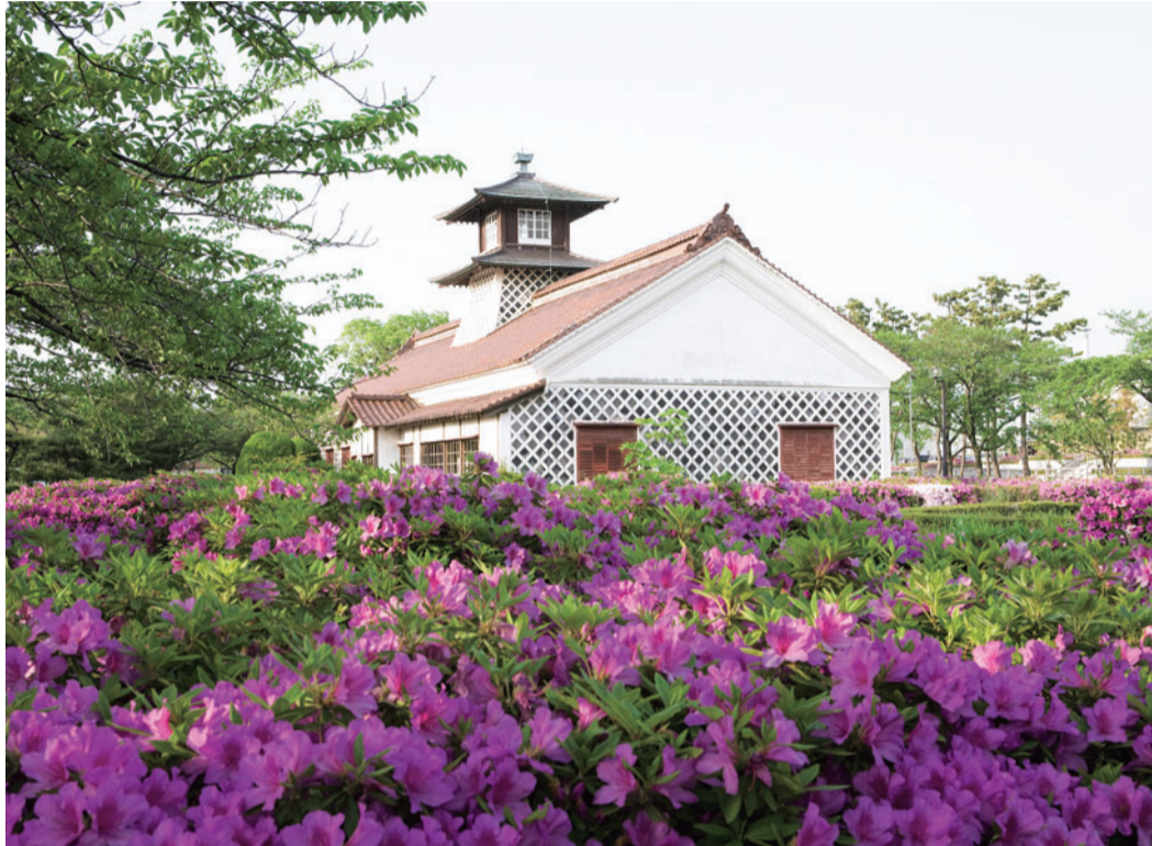
開港当時の税関の建物として開港5港の中で唯一現存する旧新潟税関庁舎。昨年11月に耐震補強等を完了し、開港150周年を迎えた本年1月にリニューアルオープンしました。
