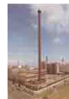
レインボータワー工事
